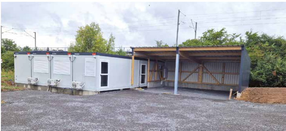
Aufbau der Containerwache
